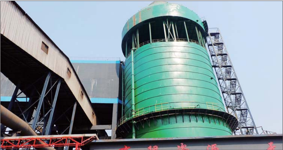
停产整顿期间,临沂江鑫钢铁投资8000万元对烧结机、铸铁机等进行除尘改造。
