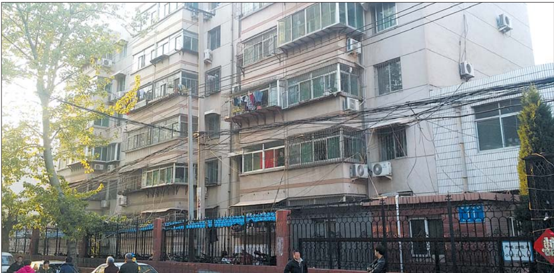
►使用自备井经常停水的姚家小区。 本报记者 蒋龙龙 摄
