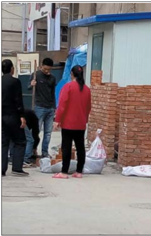
居民正在建的储藏室。见习记者 孙业文 摄
