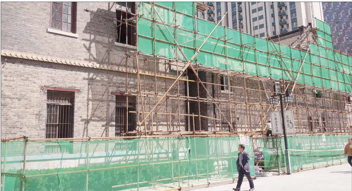
红卍字会诊所旧址外围正在清理污损墙面。
