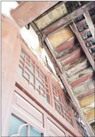
破损的楼梯和门框也将进行修缮。
