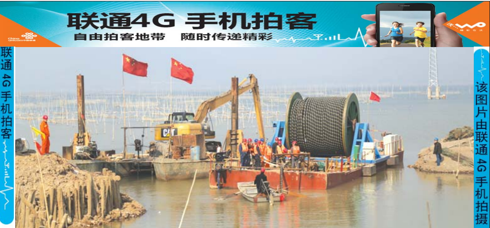
工人们现场敷设电缆。 本报记者 王世腾 摄
