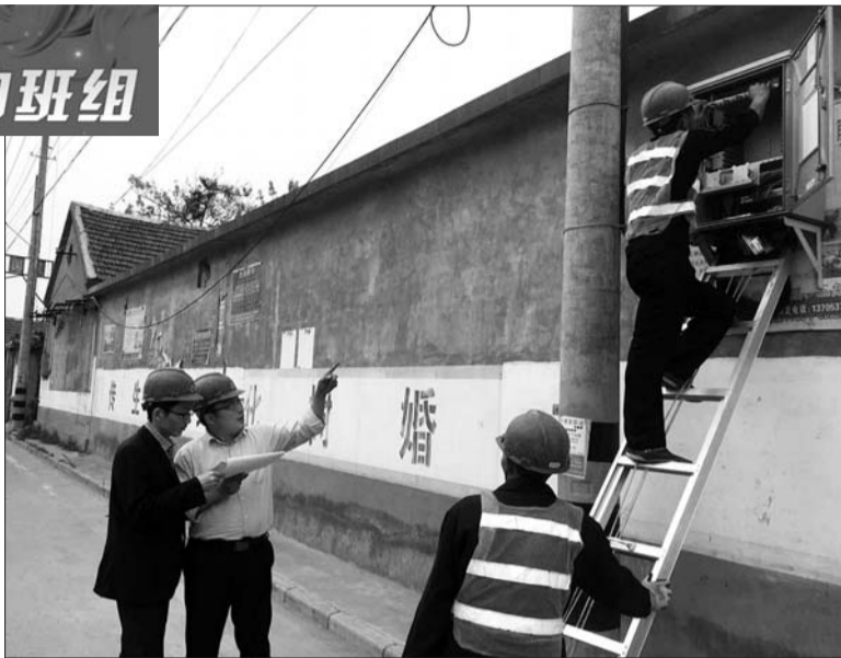
戴伟(左二)和工作人员在曲阜农村安装数据箱。
