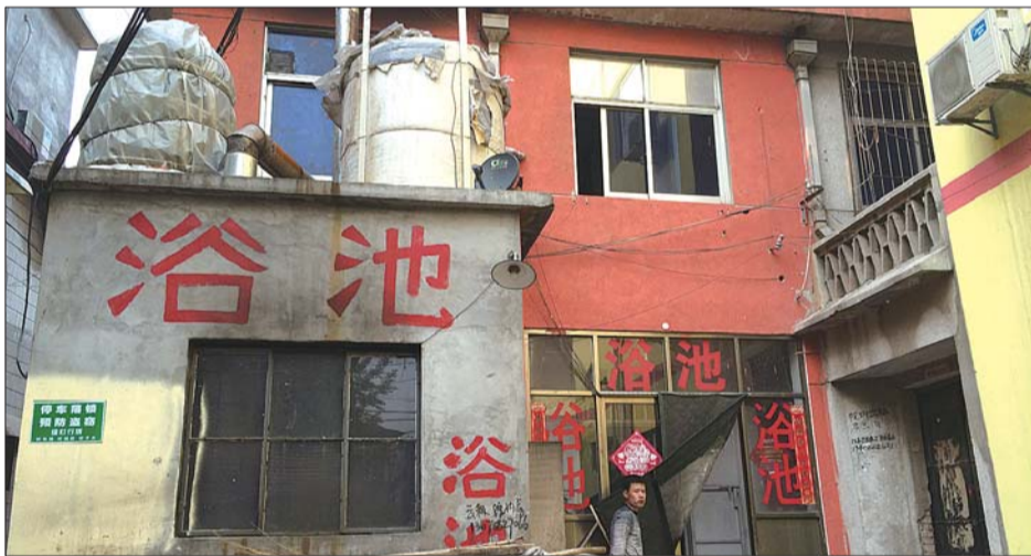
常见的公共浴池大都是用锅炉烧水。
