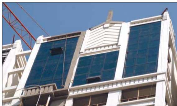
▲住宅上部玻璃幕墙,增加建筑物的美观度。
