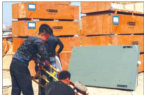
▲沈阳总厂三洋电梯,世界名牌,安全保障。图为:施工人员正在紧张的安装电梯。
