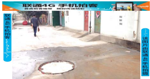
漏水一天多,地面已经湿透。本报记者 赵兴起 摄
