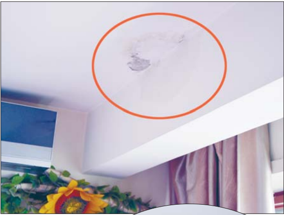
▲屋顶墙皮已经开始发霉脱落。
