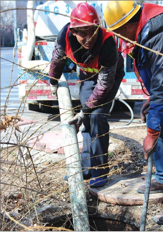
▲新立河流域内的雨污水管道清淤。
