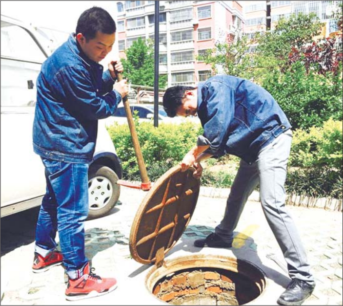
工作人员要对辖区内的所有地井阀门进行检修。
