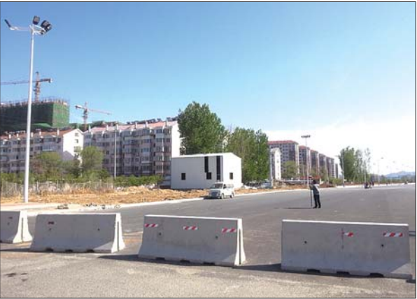
长安路正加紧施工建设。 本报记者 侯艳艳 摄
