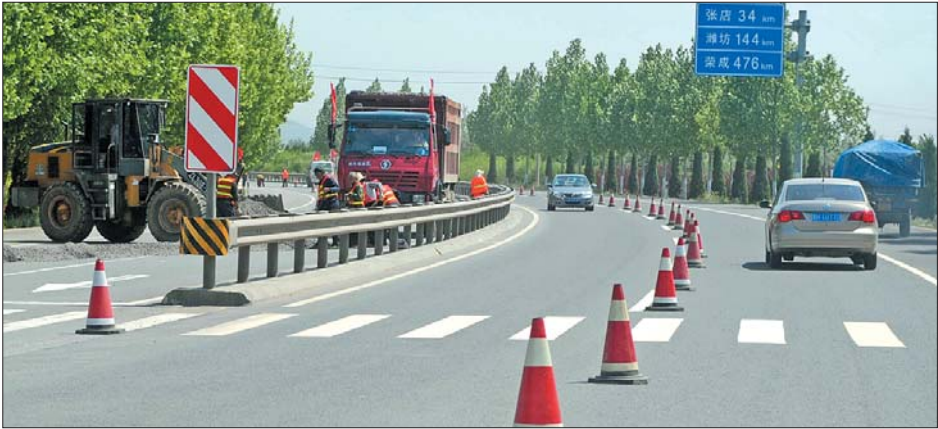
12日,济南经十东路(309国道)济南至章丘段大修,总共将近30公里的路段单向封闭施工,部分破坏严重的路段被彻底掘开重铺,汽车不得不单幅并道行驶。 本报记者 周青先 摄
