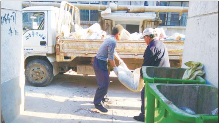
◀ 红星小区牵缘物业公司工作人员正在清理建筑垃圾。本报记者 范少伟 摄
