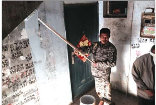
工人正在粉刷墙壁。 本报记者 陈新 摄
