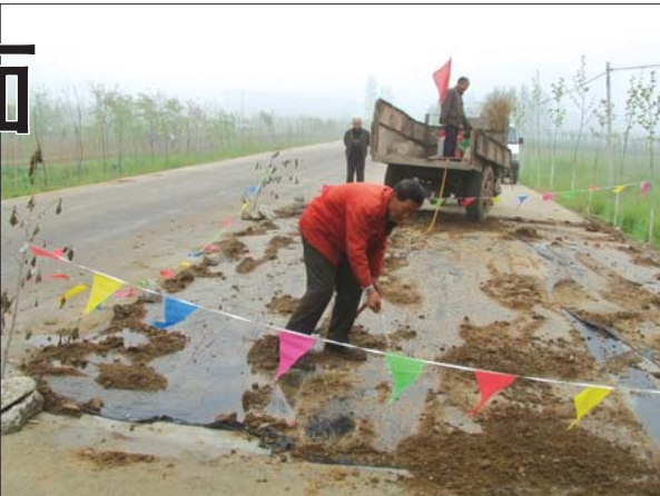
公路养护人员正在对道路进行修补。 本报通讯员 供图 截至目前,全镇已有900余人投入到公路养护工作中,完成坑槽修补2800余处,保养路段7000平方米。
