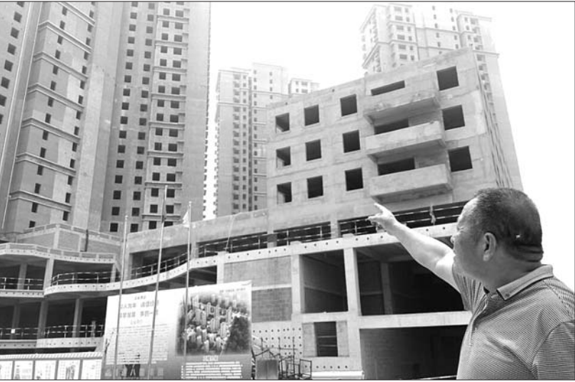
近日,65岁的杜树民常常到工地上看自己购买的保障房何时能再开工建设。(资料片)
