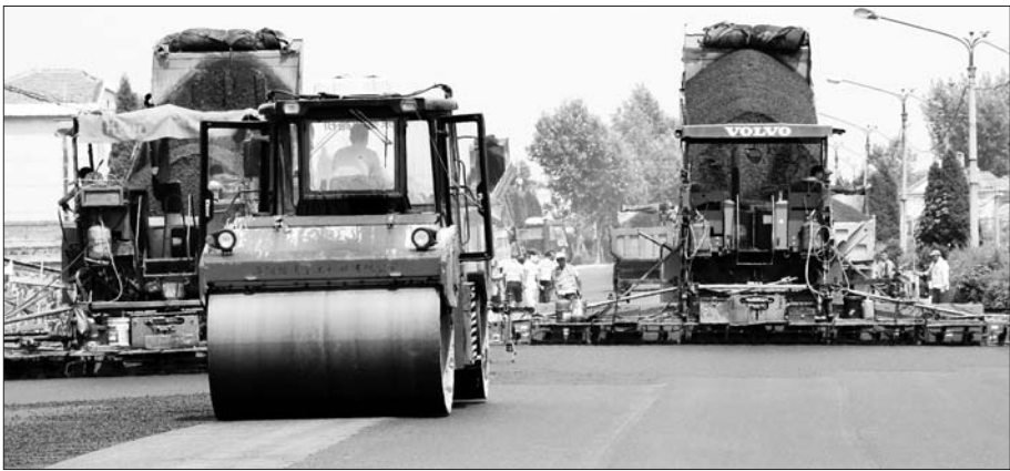
省道海莱线招远境大修施工现场。 通讯员 李其波 摄
