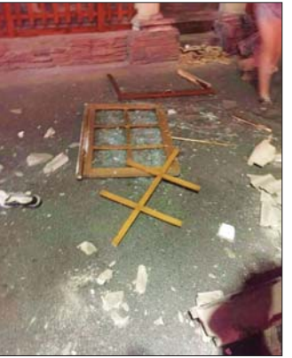
事发现场还有坠落物残渣及被坠落物砸下的一扇窗户。 图片由刘先生提供
