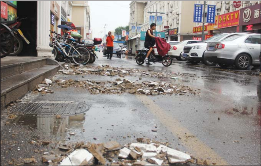
针对外墙装饰又现坠落现象,步行街管委会对部分危险装饰拆除。 本报见习记者 李洋 摄
