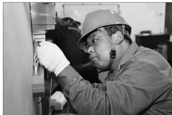
滨州供电公司工作人员为客户装表接电。(代福永 摄)
