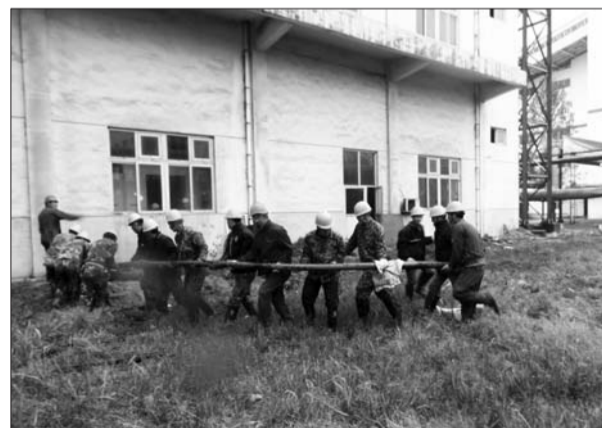
滨州供电公司工作人员在220千伏官庄站110千伏配出工程一线敷设电缆。(代福永 摄)
