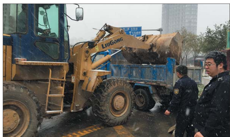
工作人员冒雪清理撒漏渣土。本报记者 王小蒙 摄
