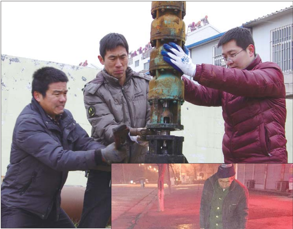
▲济北水厂维修潜水泵。 赵路 供图
