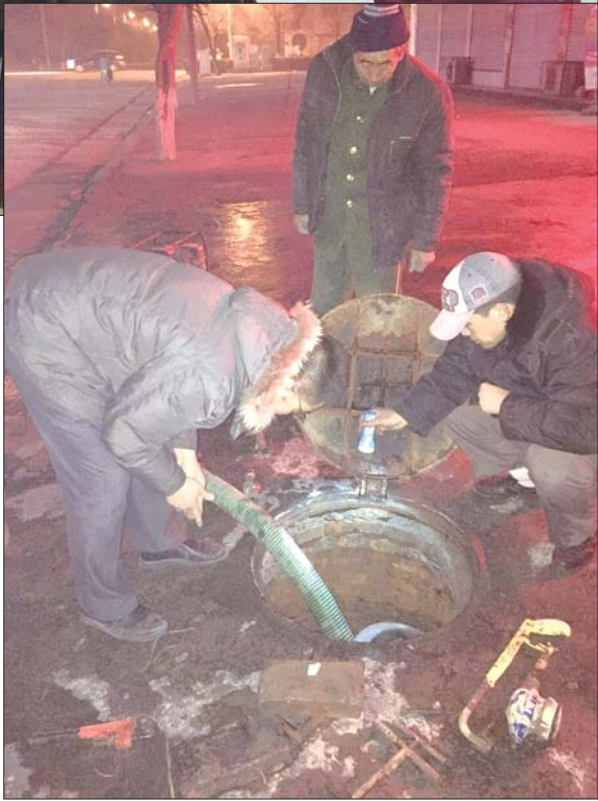
▲济北水厂维修潜水泵。 赵路 供图
