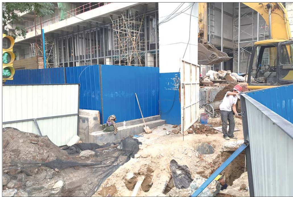
18日下午，济南中心房地产项目北门外在开挖施工。
