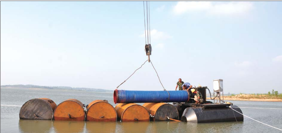
工作人员正在安装二次导水设备。侯军友 摄。
