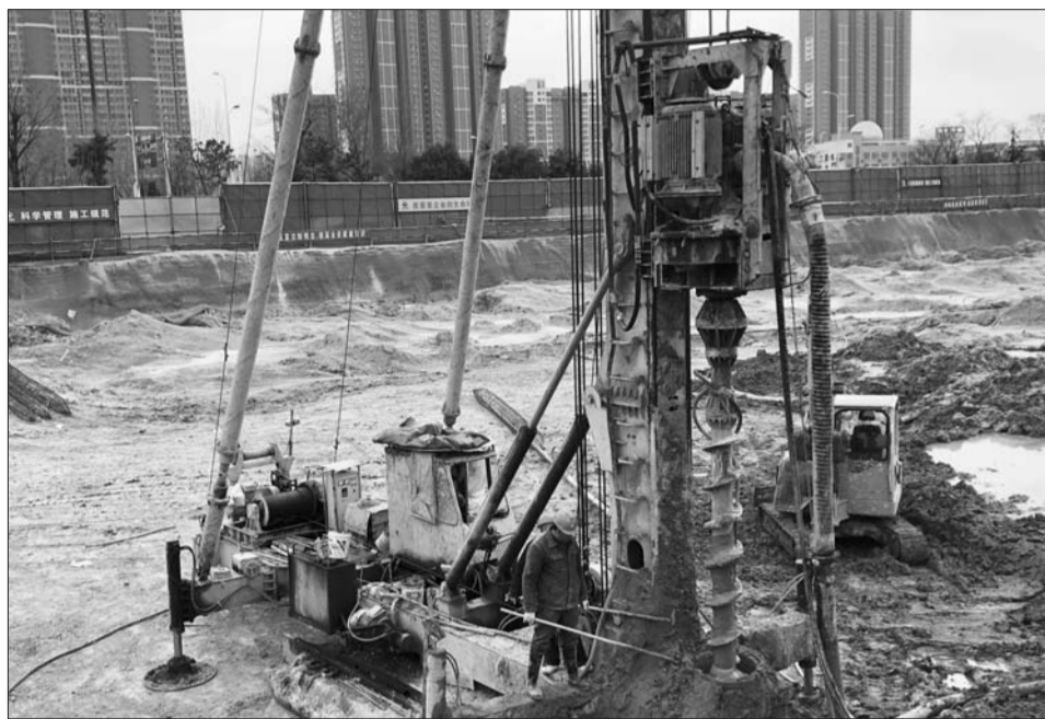
施工人员现场清理打桩机残留泥土。本报记者 马云雪 摄
