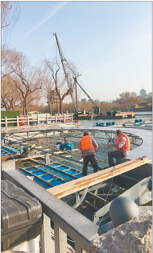
半月形水幕正在施工。
