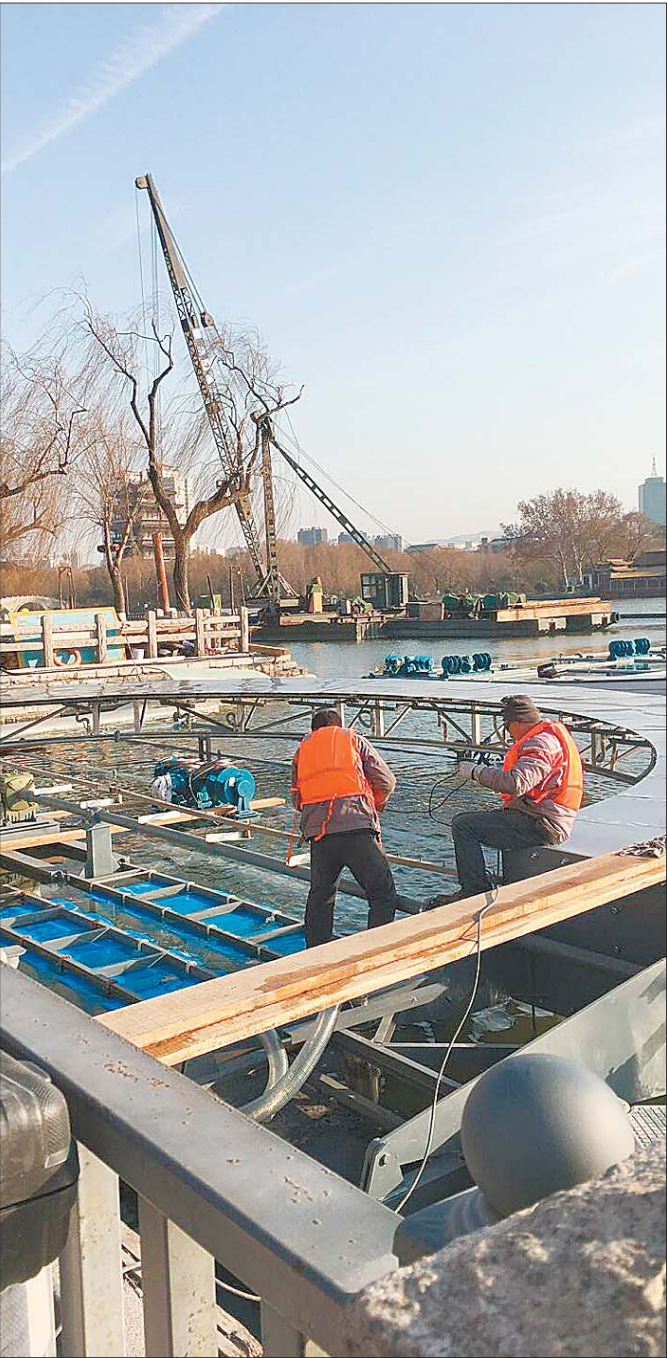
半月形水幕正在施工。
