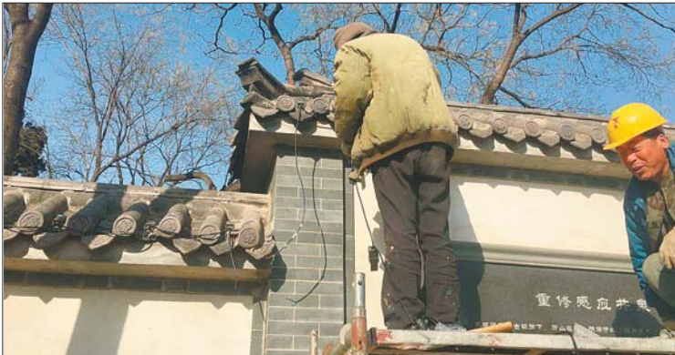
大明湖公园内,工人们正在给建筑安装瓦楞灯。
