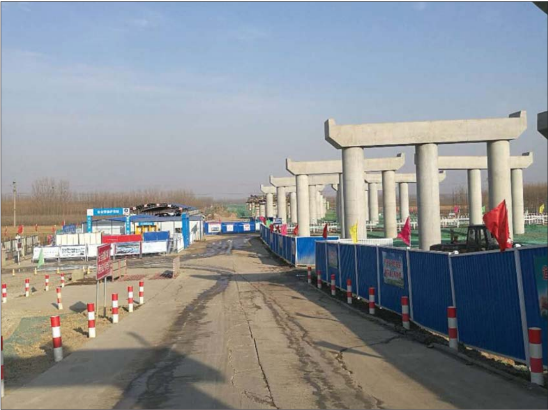
京杭运河大桥61棵墩柱已施工完毕。 本报记者 孔令茹 摄
