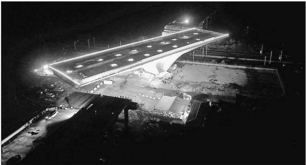
历经90分钟匀速转动,“巨无霸”V形墩转体桥实现精准对接。 本报记者 周青先 摄
