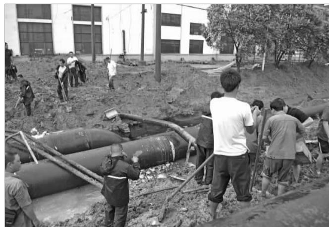
工作人员抢修供水管道。刘守善 摄
