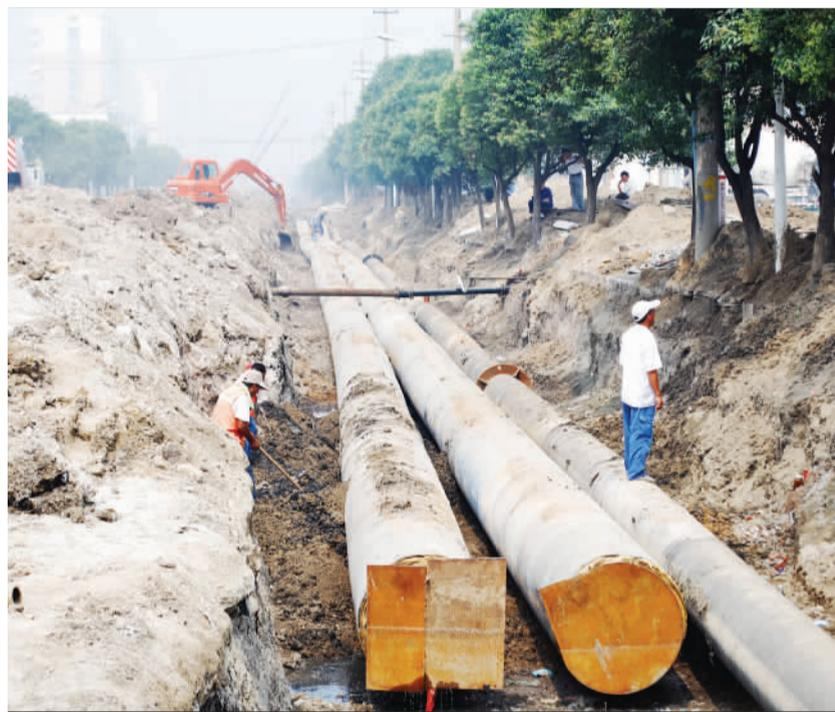
6日上午,记者从济宁市太白楼路东段看到,东郊热力公司负责铺设的热力管道已进入回填阶段。据介绍,工作人员将力争10日内完成回填工作,该路东段快车道部分也将进入路面铺设阶段,预计太白楼路全段于9月初完成路面整治。 本报记者 刘守善 摄
