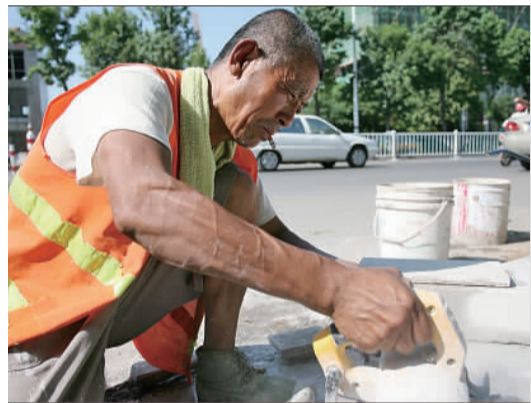
胜利街上,施工人员在高温下安装路沿石。
