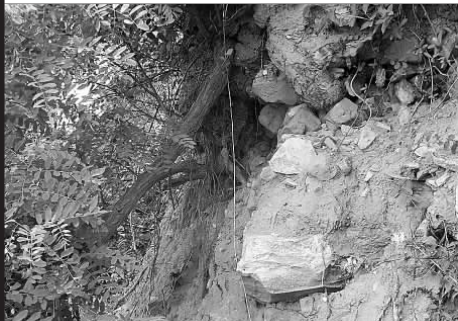
北城墙东段残垣中,块石历历。
