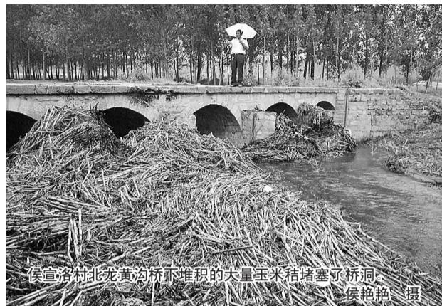
侯宣洛村北龙黄沟桥下堆积的大量玉米秸堵塞了桥洞。
