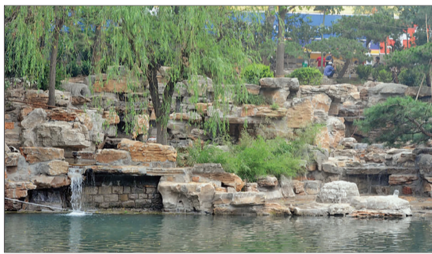
7月14日,在护城河白石泉以西到南门桥桥洞之间,一处正在施工的新景观——假山瀑布已具雏形。
