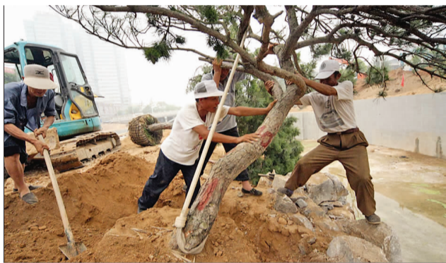
7月14日,在东护城河船闸工程上,工人正在移植松树。
