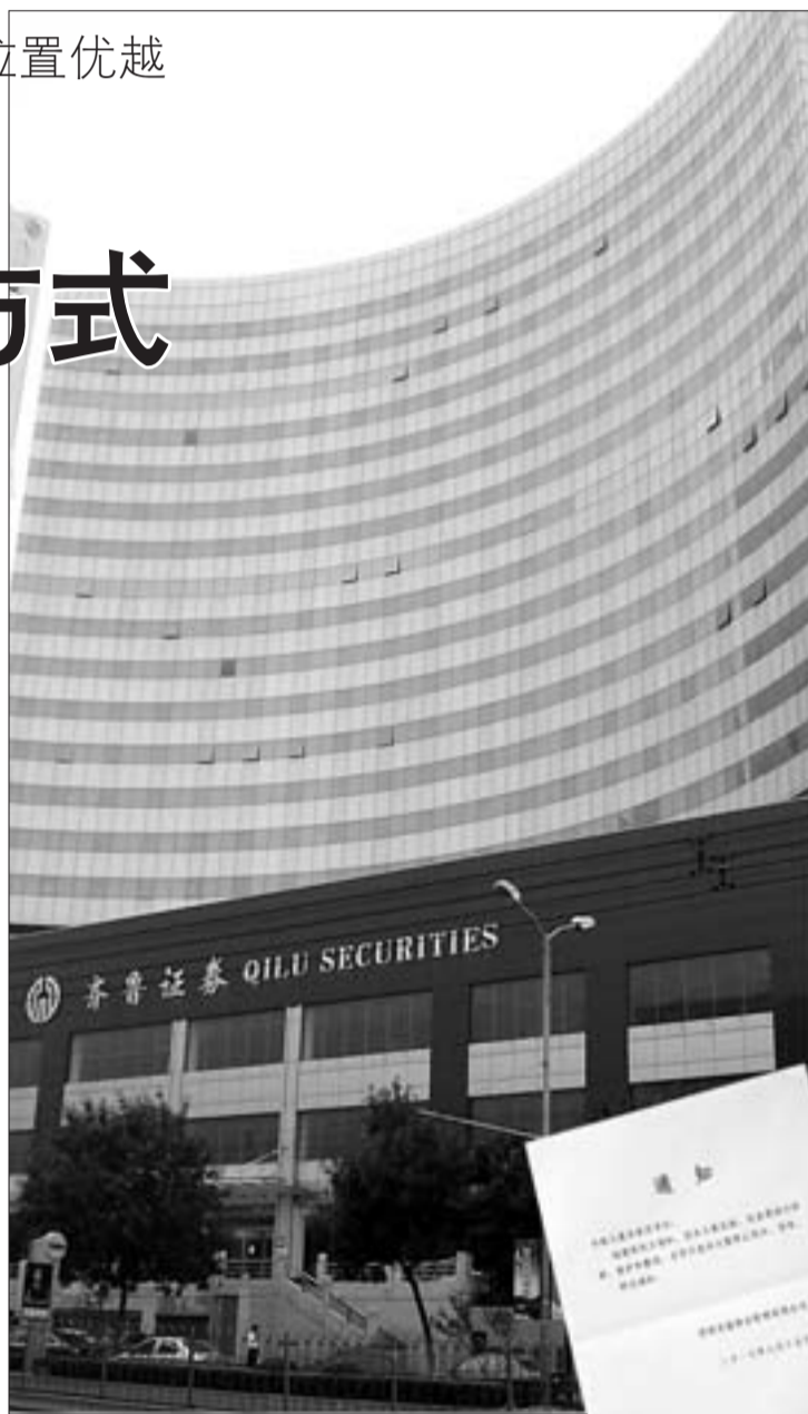
▲中银大厦二期大楼。 ▶济南东盛物业管理有限公司贴出的通知。 本报记者 王光照 摄
