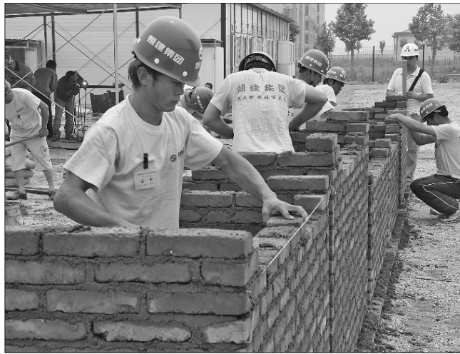
在烟台一工地上，建筑工人正在砌墙。 本报记者 刘新 摄
