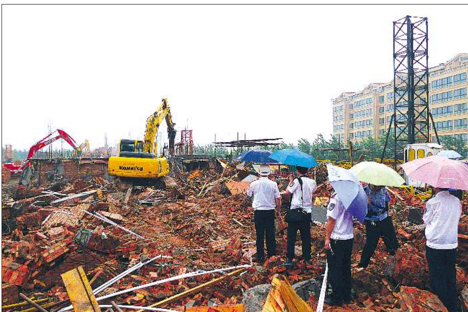
▲挖掘机冒雨开工地。本报记者 邱祎 摄
