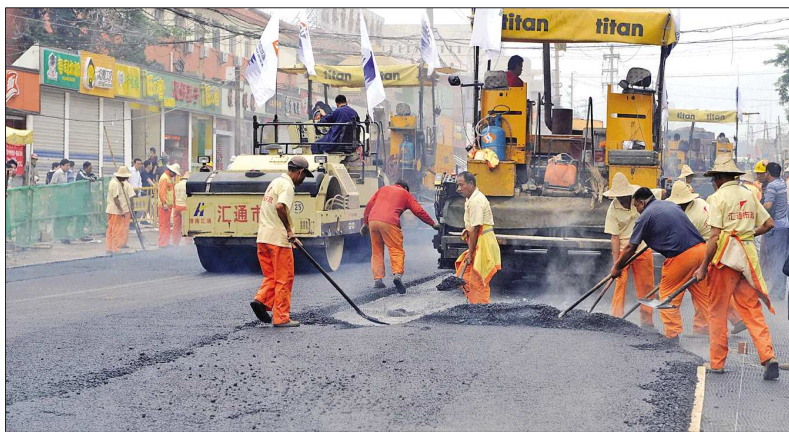
28日上午,济南文化东路改造工地,施工机械开始铺设柏油路面,这意味着这条道路的改造已经进入尾声。 本报记者 周青先 摄
