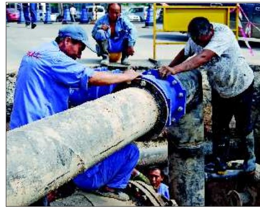
工作人员正在进行最后的施工准备。本报记者 赵伟 摄
