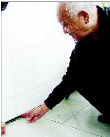
阳台与居室墙体的缝隙约有4厘米。 本报记者 刘铭 摄
