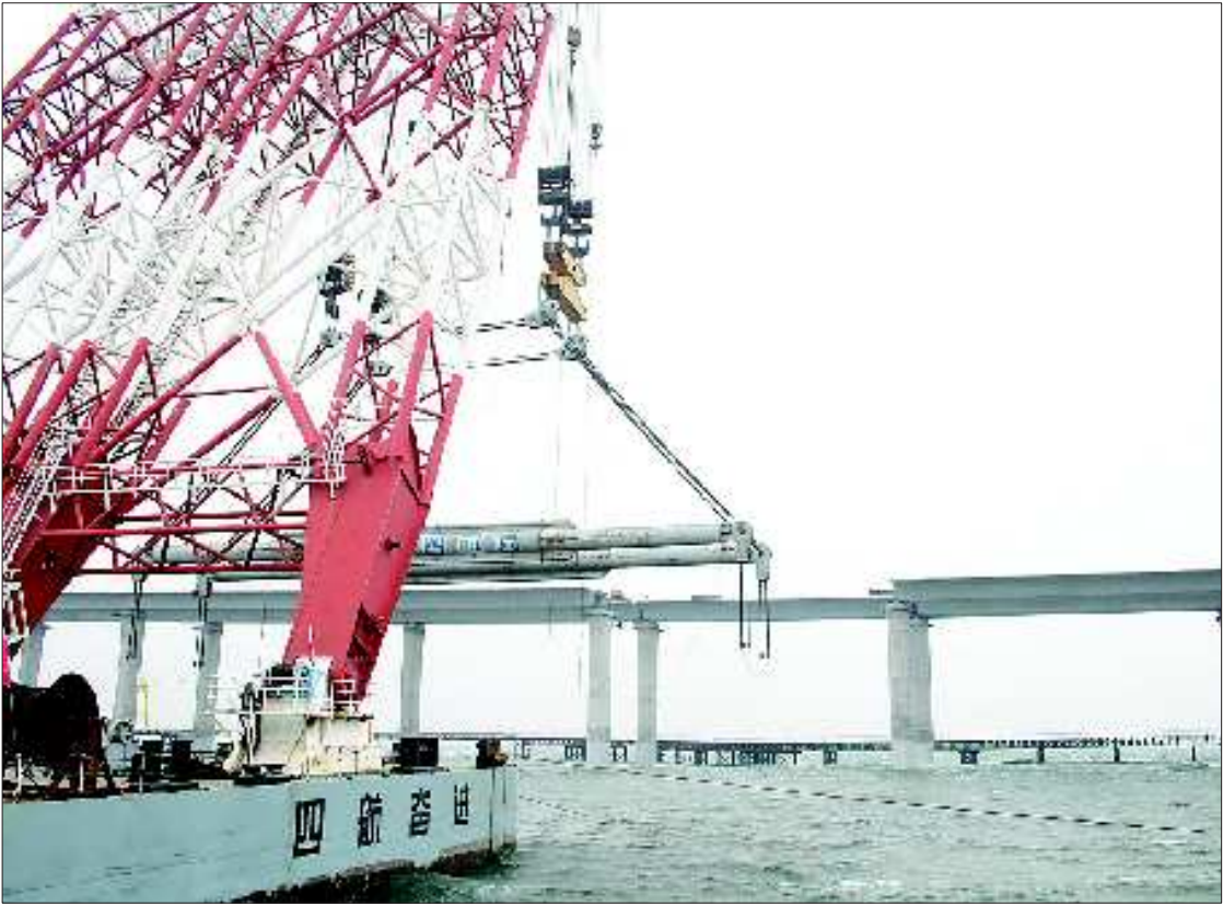
奋进号正准备吊起最后一片预制箱梁进行安装。 本报记者 管慧晓 摄
