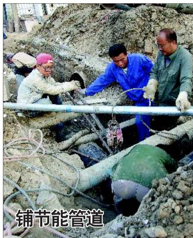
9月29日,工作人员正在德城区罗庄焊接新更换的暖气管道。据悉,这种供暖管道将改变原有的供暖传输方式,大大降低暖气在传输中的损耗。
