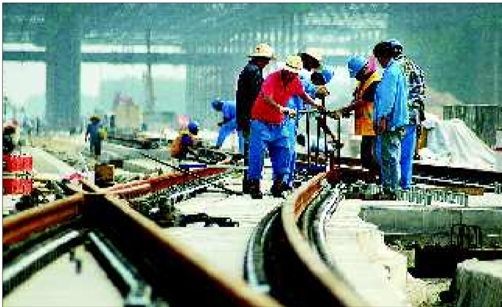
正在建设中的京沪高铁项目,为德州的城镇化建设带来新的发展契机。 本报记者 马志勇 摄
