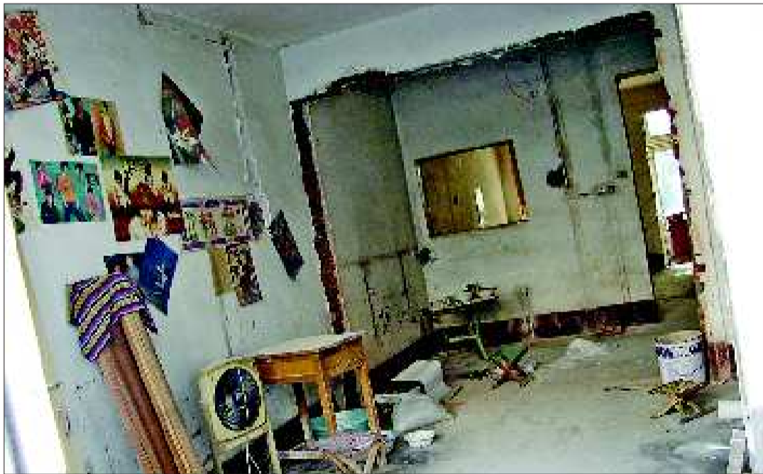
一楼房屋内的两堵承重墙已被拆除。 本报记者 刘铭 摄
