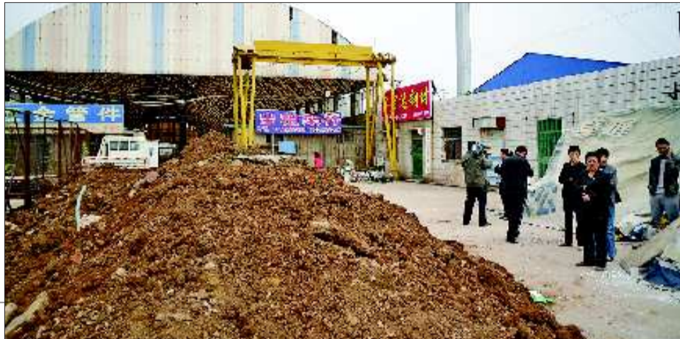
市场南门外堆满渣土。本报记者 姬生辉 摄
