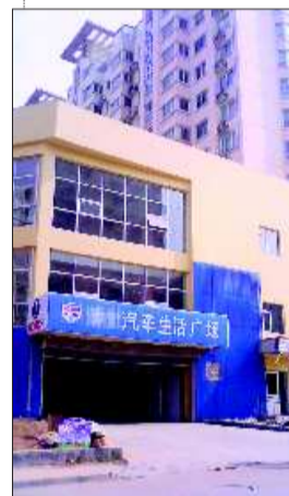
开发商卖出的地下车库已经建成商铺, 引发业主不满。刘铭 摄
