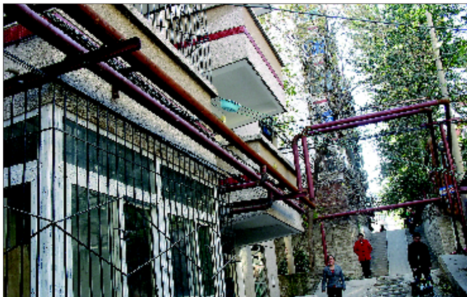
小区内已经架上管道,能及时通上暖气吗?
