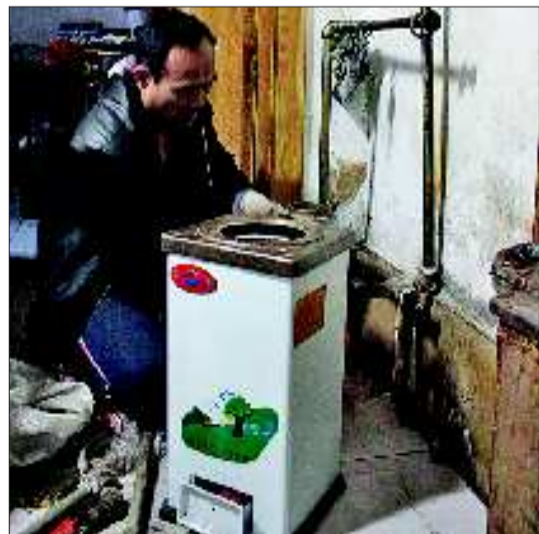
韦贞福大娘家,街道和社区送来的新煤炉正在安装。本报记者 赵恩霆 摄
